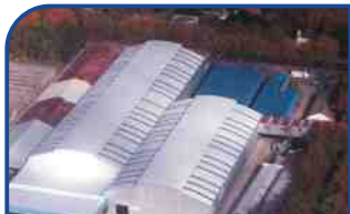
Techos de chapas
