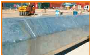
Reparación de galvanizado
